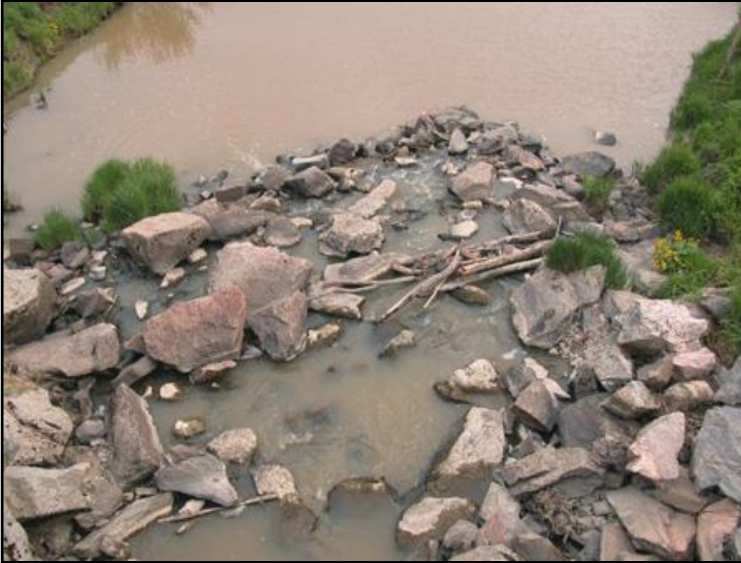
Kuva 5 Kivikkoa sillan päältä kuvattuna
