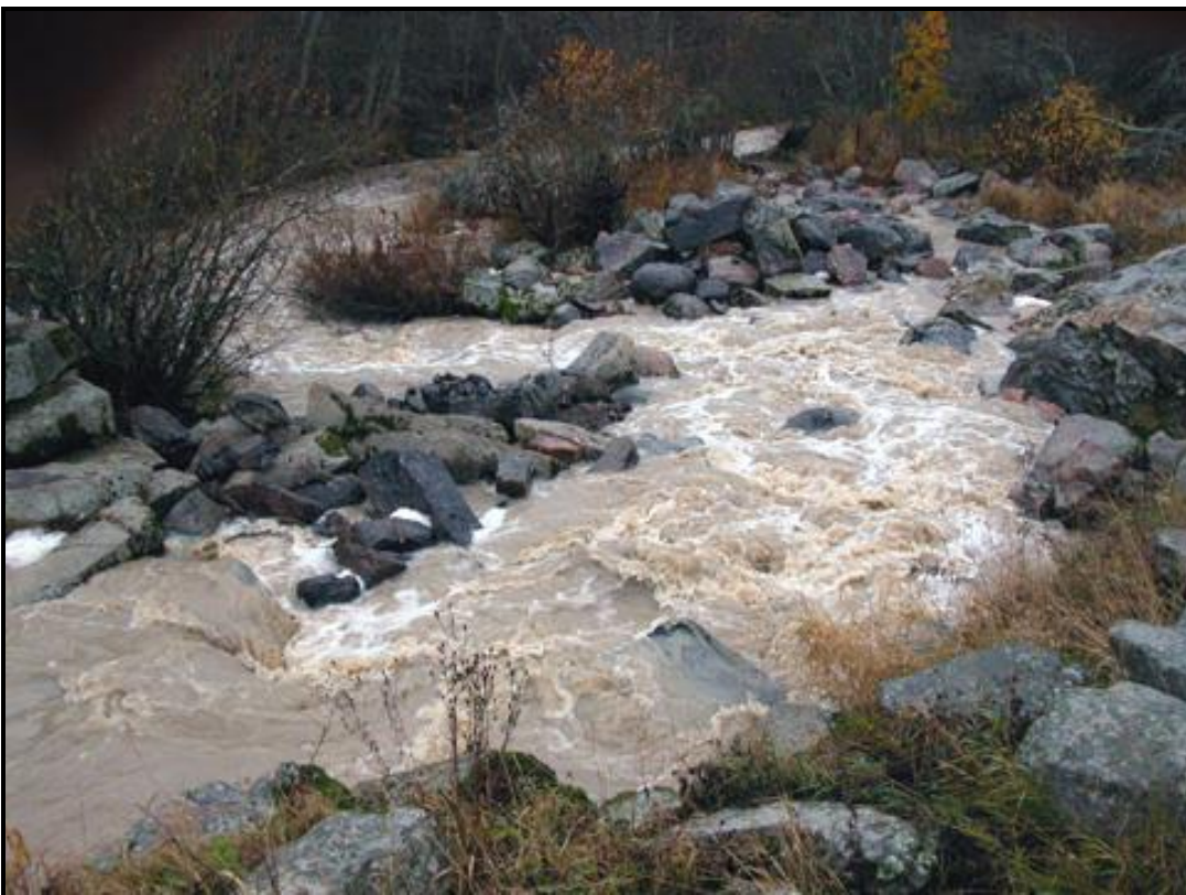
Kuva 4 Kalatie ylhäältä kuvattuna rakentamisen jälkeen
