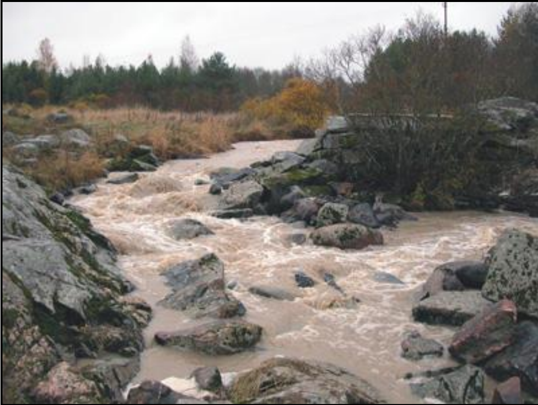
Kuva 3 Myllypadon sortunut osa kalatien rakentamisen jälkeen
