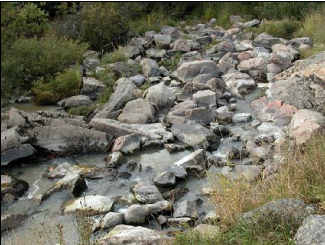
Kuva 2 Patoon sortunutta osaa alavirtaan päin
