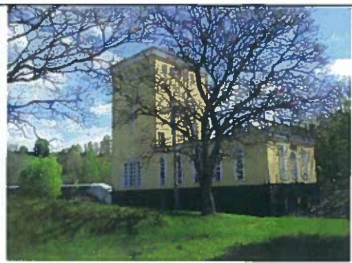
Kuva 4. Askalan vesivoimalaitos alavirran puolelta kuvattuna.
