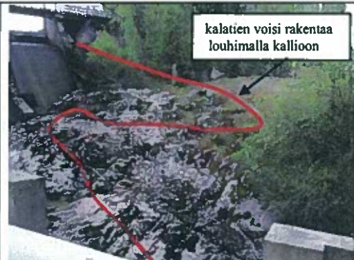
Kuva 18. Juvan betonipadon länsireuna alavirran puolelta kuvattuna
