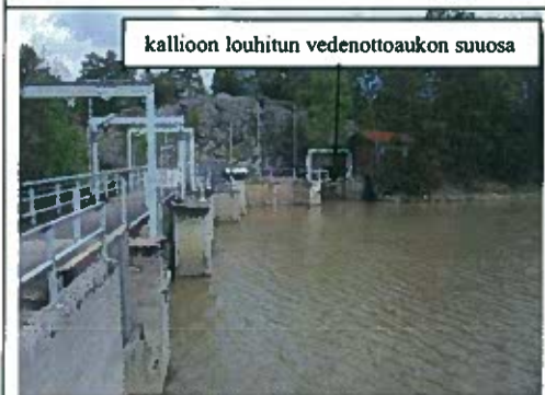
Kuva 19. Juvan voimalaitospato ylävirran puolelta länsirannalta kuvattuna
