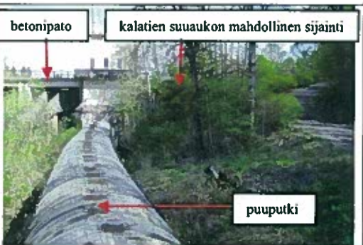
Kuva 8. Askalankosken voimalaitoksen vedenjohtoputki alavirran puolelta kuvattuna
