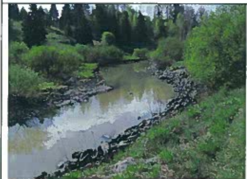
Kuva 5. Voimalaitoksen alakanavan keskiosaa kun juoksuutus ei ole käynnissä
