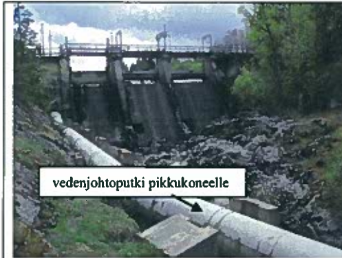
Kuva 17. Juvan vesivoimalaitospato alavirran puolelta kuvattuna
